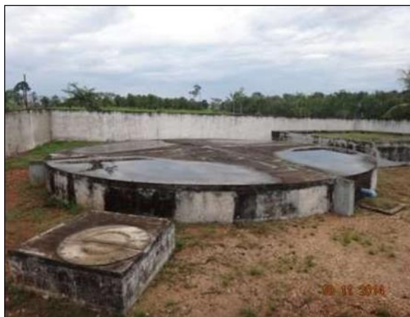
Figura 42 - Reservatório apoiado (RAP)
