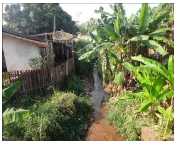
Figura 56 - Córrego onde é lançado esgoto doméstico
