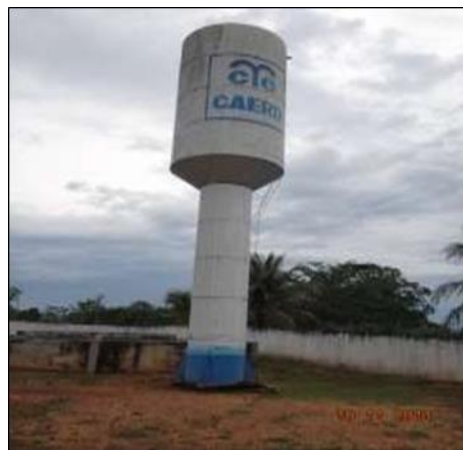
Figura 43 - Reservatório elevado (RAP)
