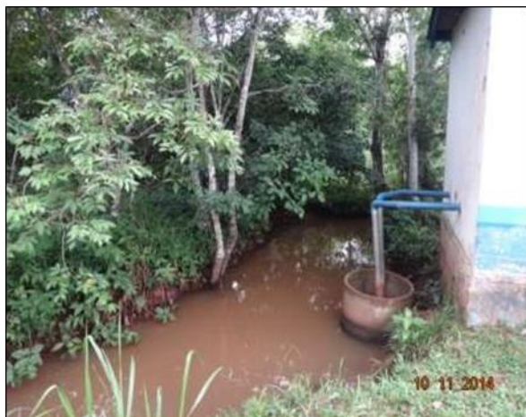
Figura 23 - Captação de água Fonte: E.C.P. Soluções (2014).
